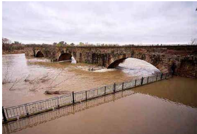
Río Tajo en el pico de la crecida, en las horas previas al derrumbe del Puente Viejo. / MANU REINO
