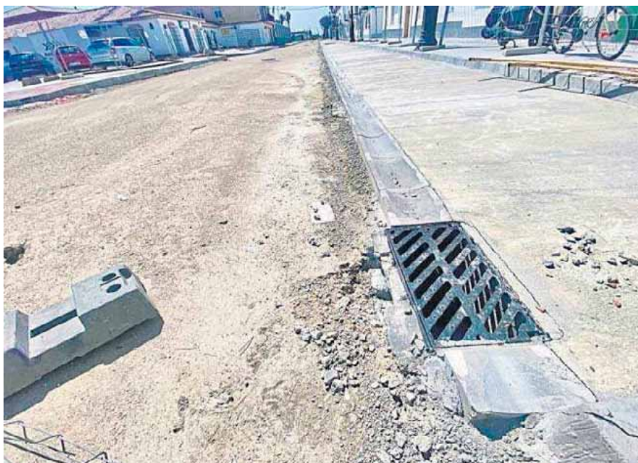
Una imagen de las obras de reurbanización de la avenida de la Bajamar.
